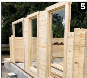
**5** (5) Hochgesteckt: Während des Aufbaus müssen Fenster- und Türrahmen rechtzeitig integriert werden
